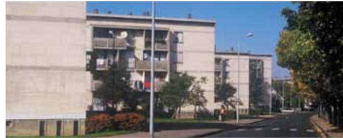
extérieurs en parpaings avec ossature de béton armé, les toîts à une pente, le manque d'isolation et de chauffage central. Les défauts de conception sont tels que de nouveaux travaux sont entrepris six ans plus tard.
